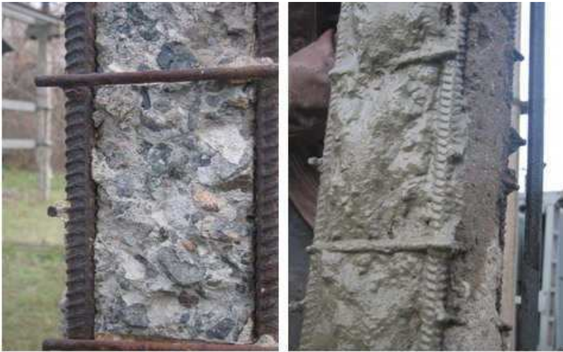
Рис. 2 Лечение и восстановление разрушенного бетона
